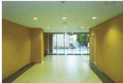
臨床研究棟玄関ホール（LED照明）
