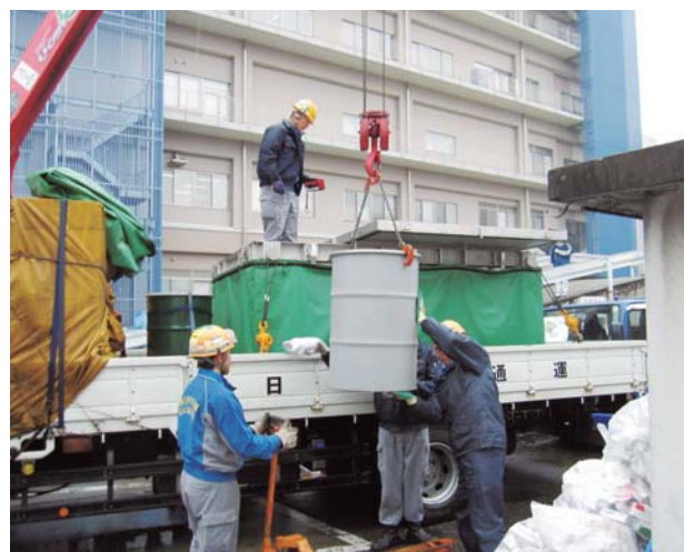
搬出作業の様子
